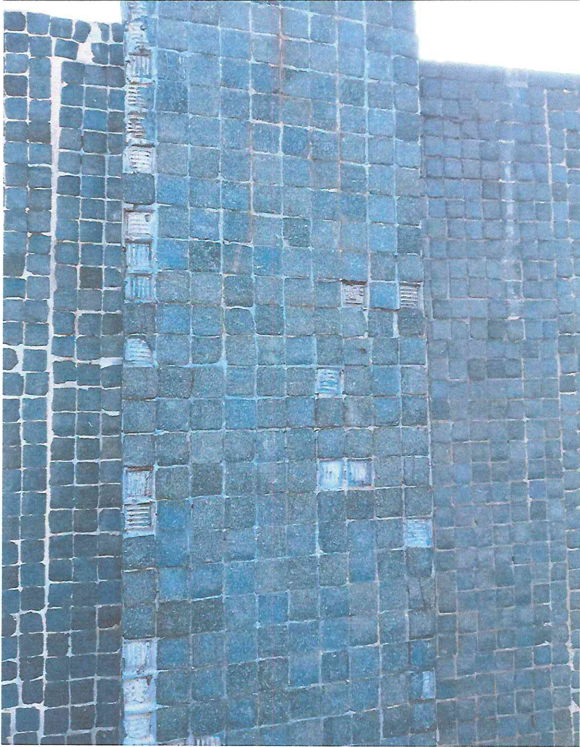
MUESTRA DE TESELA DE TONALIDADES COLOR VERDE, ZONA SIN LIMPIEZA- SEGMENTO PA2.
